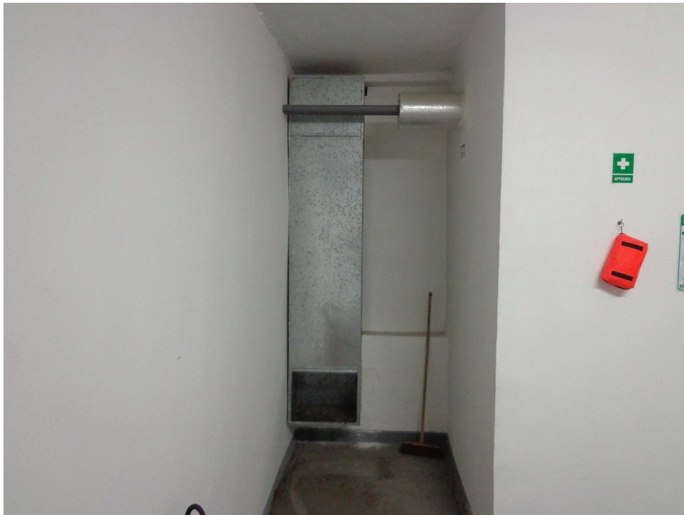
Fot. Istniejąca czerpnia powietrza.
