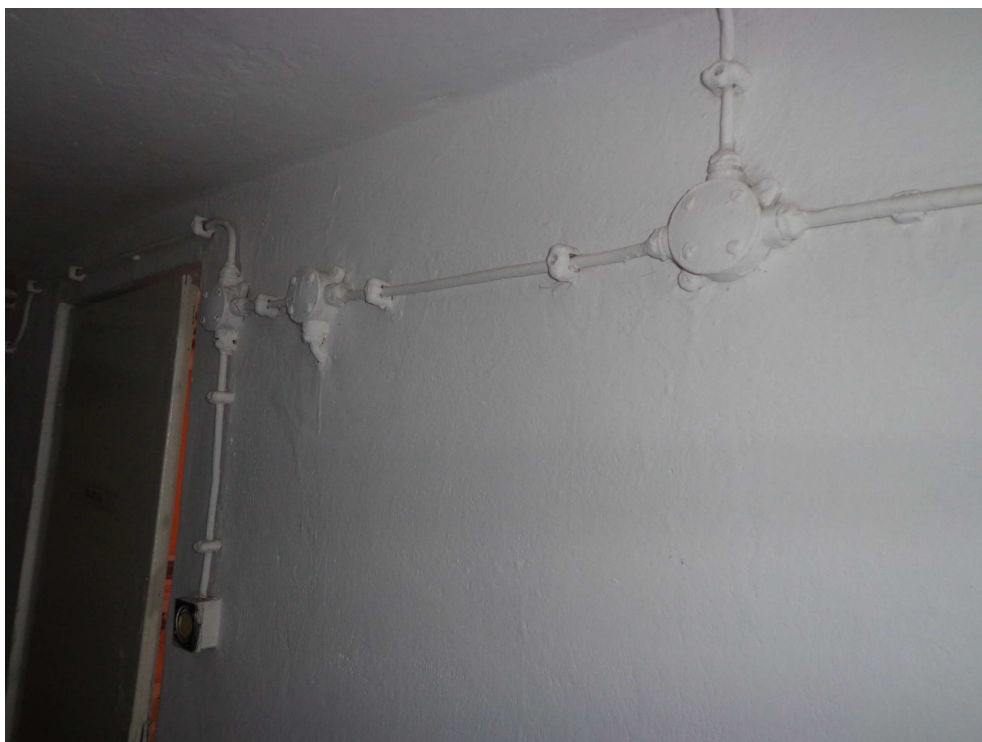
Fot. Istniejąca instalacja elektryczna do przebudowy.
