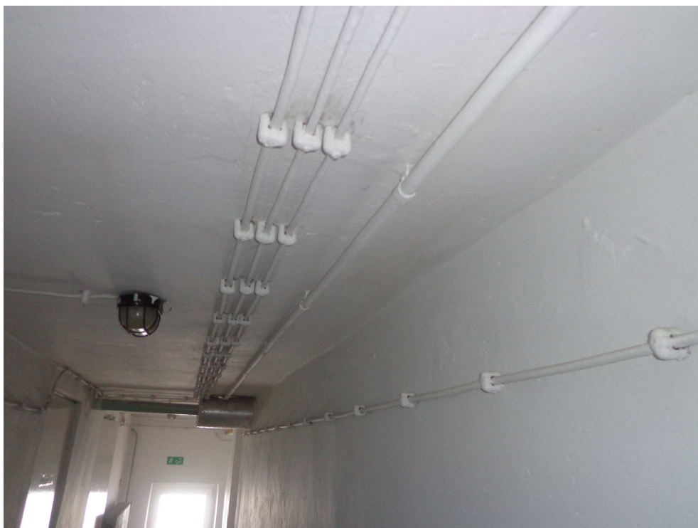
Fot. Istniejąca instalacja elektryczna do przebudowy.
