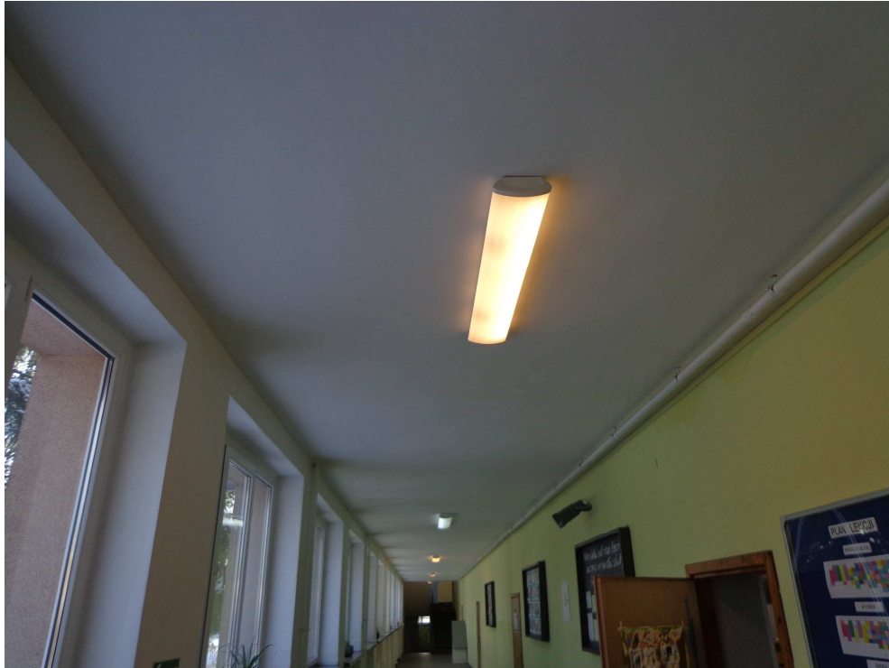
Fot. Istniejąca instalacja elektryczna do przebudowy.
