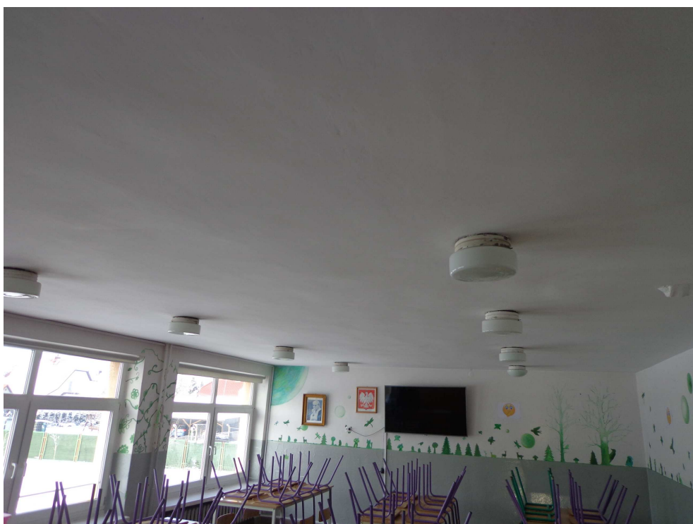
Fot. Istniejąca instalacja elektryczna do przebudowy.
