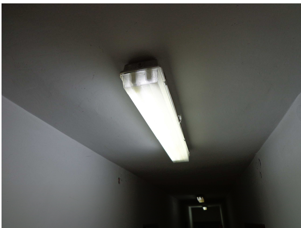
Fot. Istniejąca instalacja elektryczna do przebudowy.
