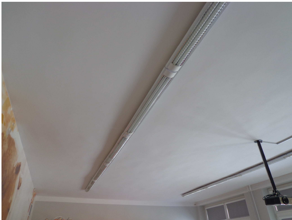
Fot. Istniejąca instalacja elektryczna do przebudowy.
