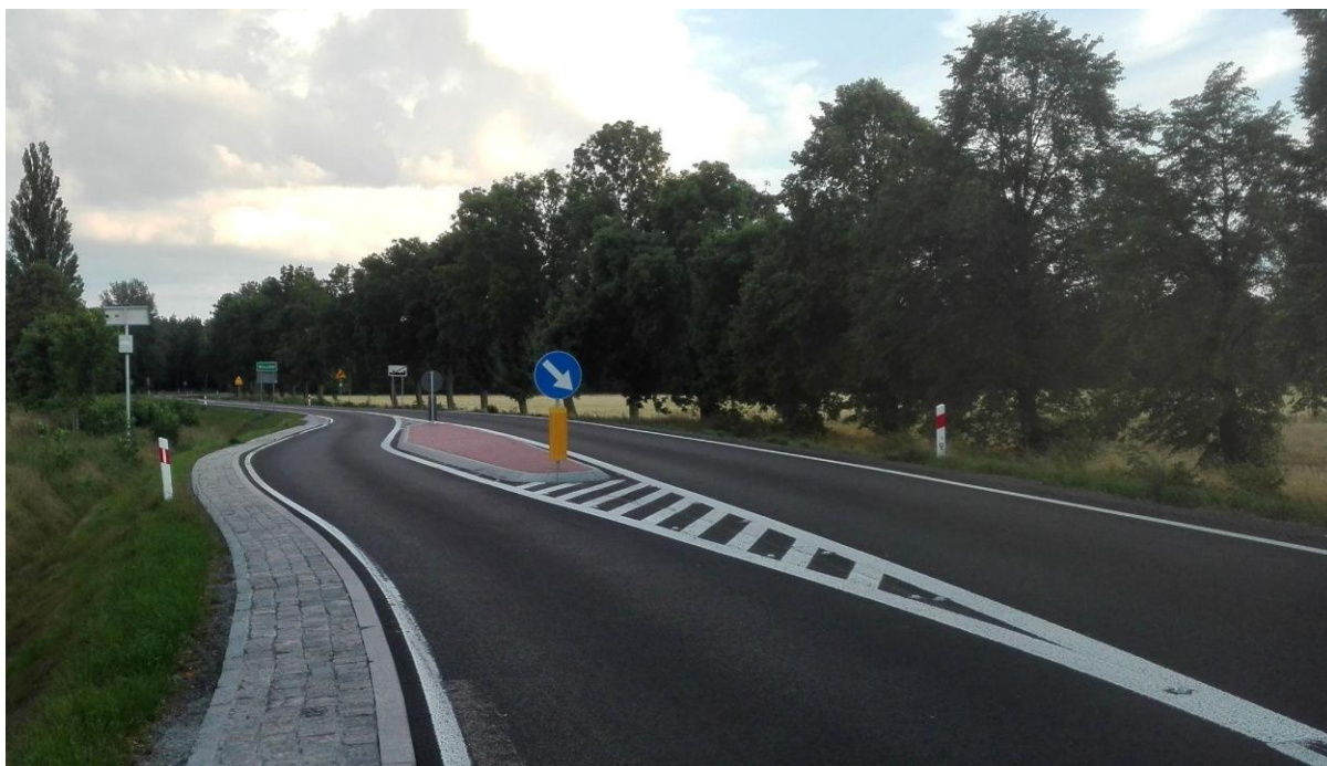
Ilustracja 4 Uspokojenie ruchu przy wjeździe do miejscowości
