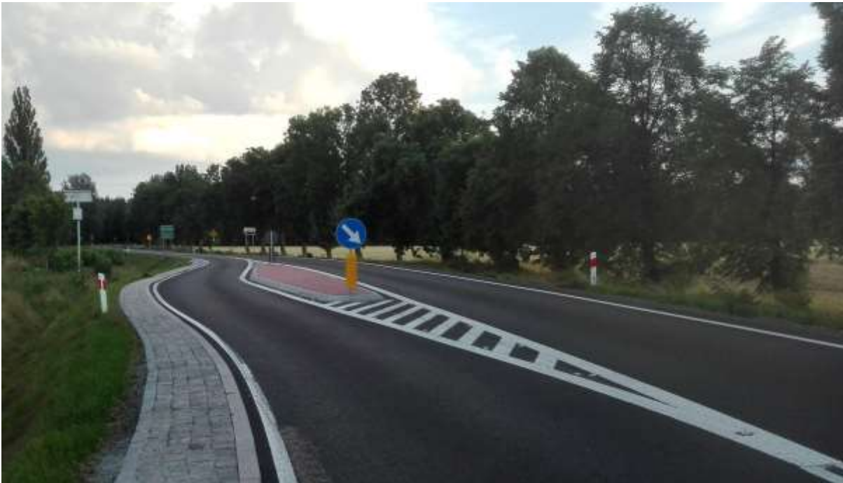
Ilustracja 4 Uspokojenie ruchu przy wjeździe do miejscowości
