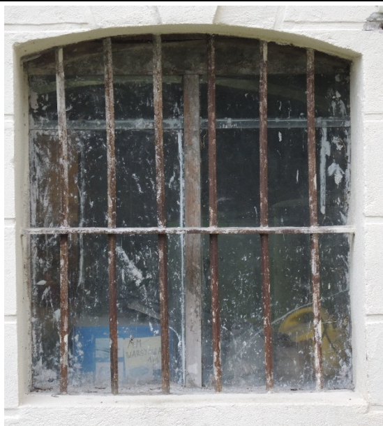
Fot. 8 Przykładowe okno w piwnicy
