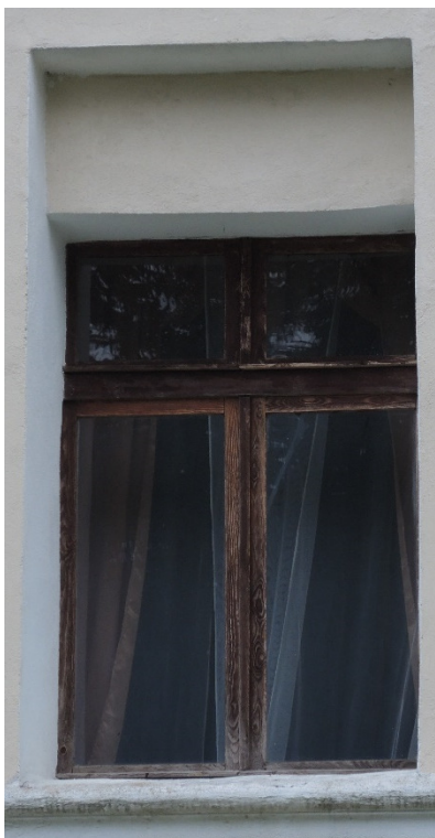
Fot. 11 Przykładowe okno w el. zachodniej
