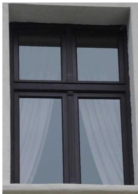
Fot. 3 Okno w el. północnej – okno z podziałem krzyżowym, szerokie profile, ciemna stolarka
