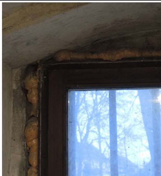
Fot. 9 Przykładowe okno w piwnicy
