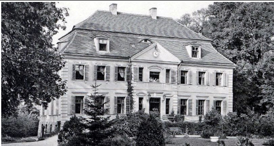
Fot. 1 Fotografie budynku pałacowego z XX w., sprzed przeprowadzenia prac remontowych z 1957 r. [źródło: biała karta obiektu zabytkowego]
