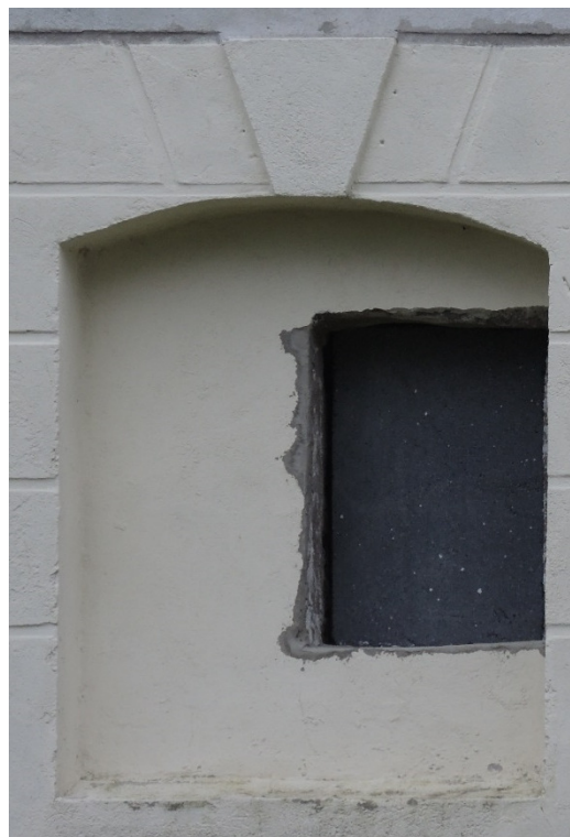
Fot. 12 Przykładowe okno w piwnicy
