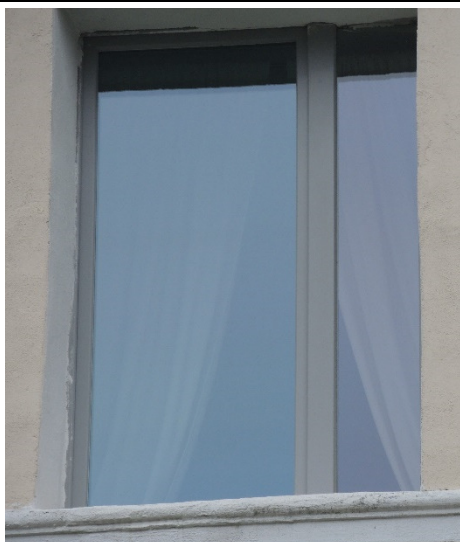
Fot. 4 Okno w el. północnej – niesymetryczny podział na dwa pola, stolarka szara
